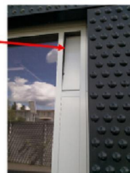
stroomvoorziening vanuit school door klapluik
